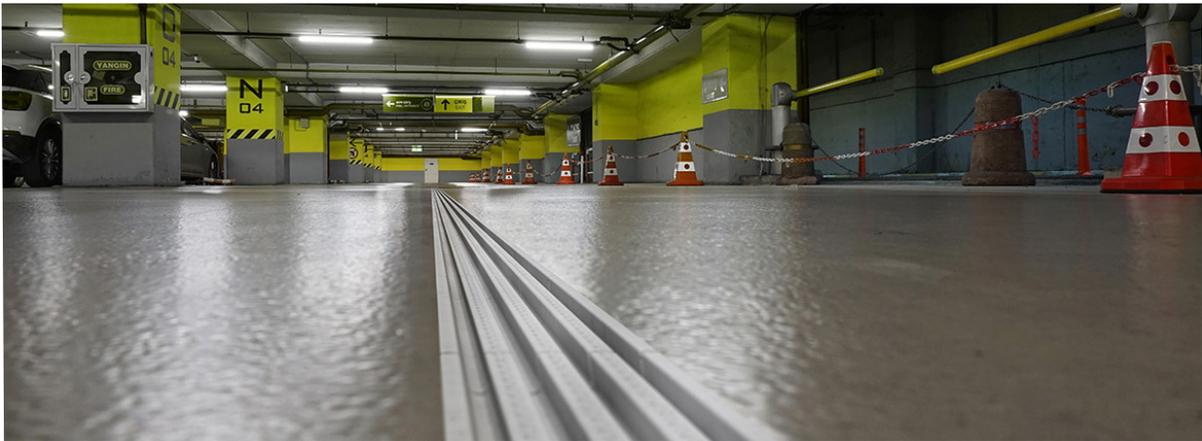
BIRCOparksafe® ist die ideale Entwässerungslösung für Parkhäuser und Tiefgaragen. Durch die monolithische Bauweise und das ebene Querprofil werden störende Klappergeräusche bei Überfahung der Entwässerungslösung verhindert.
