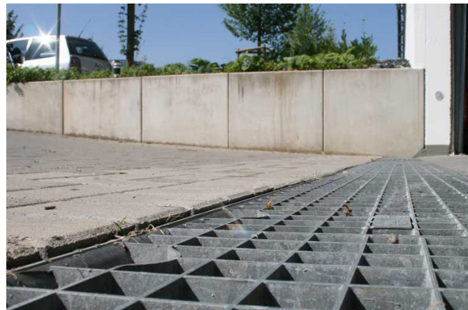
Verzinkte Gitterabdeckungen mit hohem Einlaufquerschnitt
