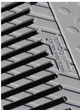
Ton in Ton, hier am Beispiel Gussabdeckung mit Tränenblech. Projekt für die Daimler AG.
