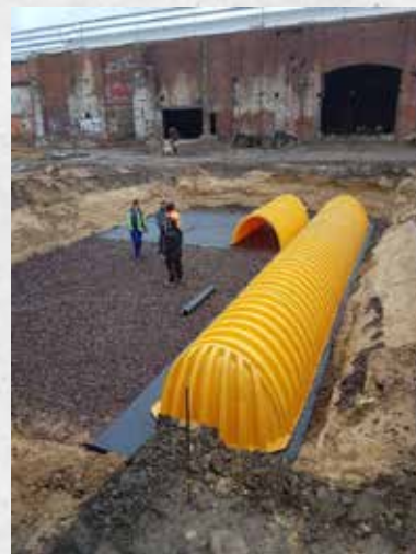
BIRCO Rigolentunnel von StormTech® Projekt Magdeburg
